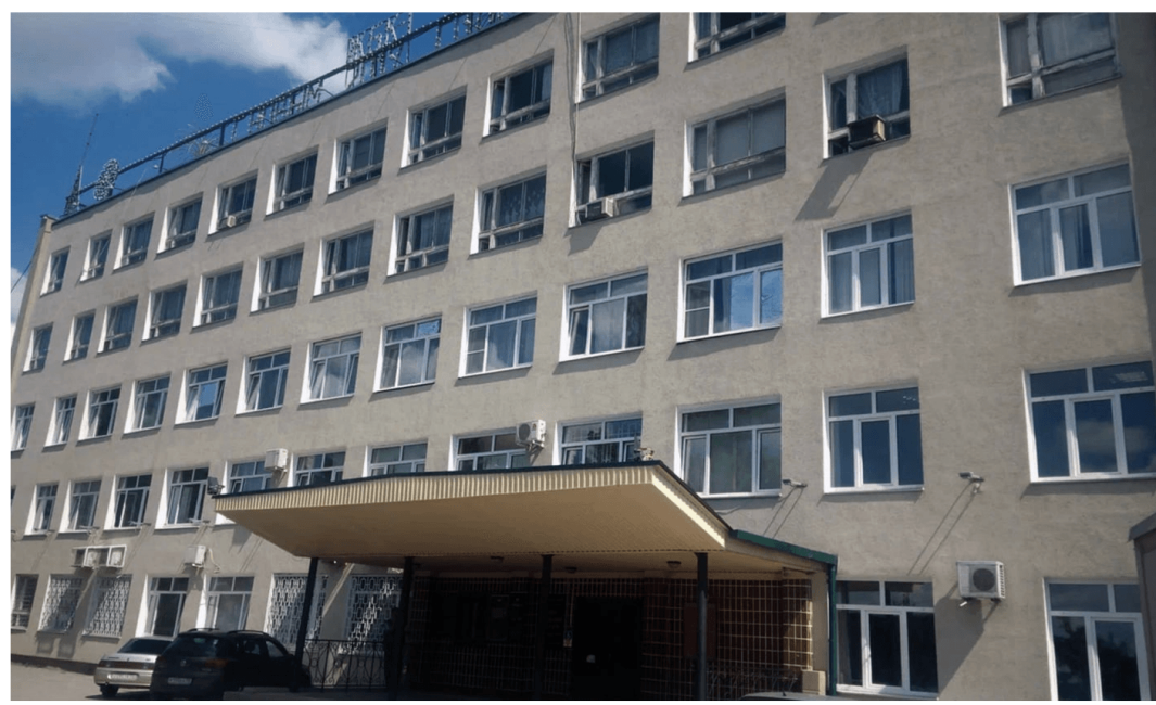
Здание военкомата Октябрьского и Железнодорожного районов Пензы. Фото: Яндекс Карты
